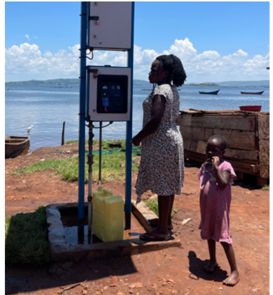
Sjálfvirkur vatnssali (AQ-tap) í fiskimannaborpi í Buikwe-héraði við Viktoríuvatn. Yfir 160 slíkir vatnssalar hafa nú verið settir upp í héraðinu.
