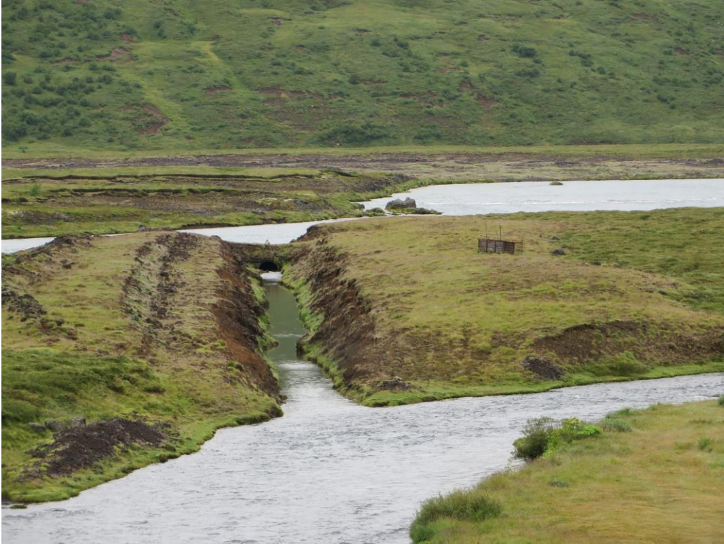
Mynd 23. Horft upp eftir veituskurði milli Skjálfandafljóts og Djúpár. Með gerð hans átti að greiða för hrygningarlaxa á efri svæði Skjálfandafljóts.
