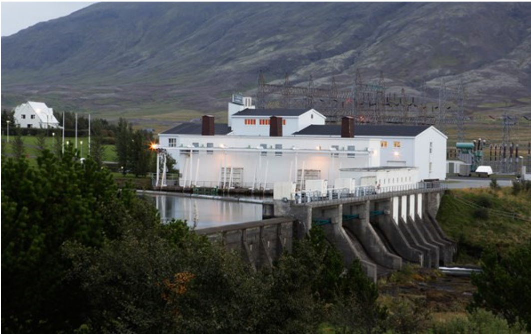
Mynd 9.2-2: Írafossstöð 48 MW (Landsvirkjun.is, 2014).
