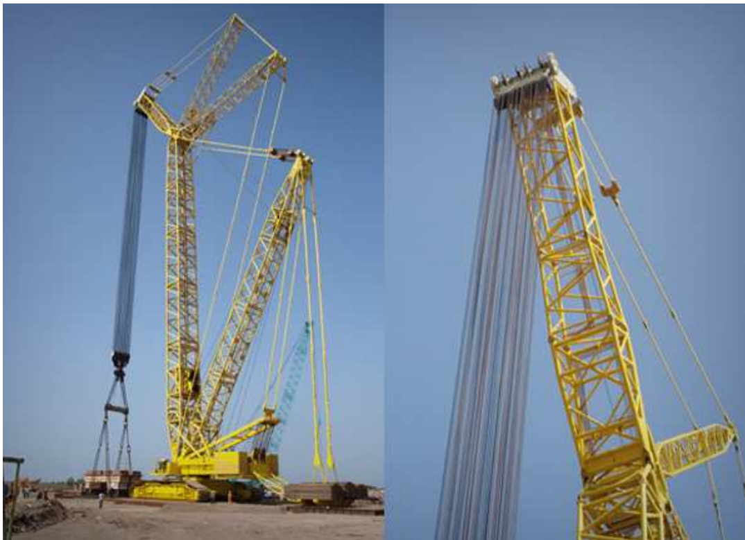
Mynd 8-5: 1600 tonna hreyfanlegur krani (Avezaa.2014).
