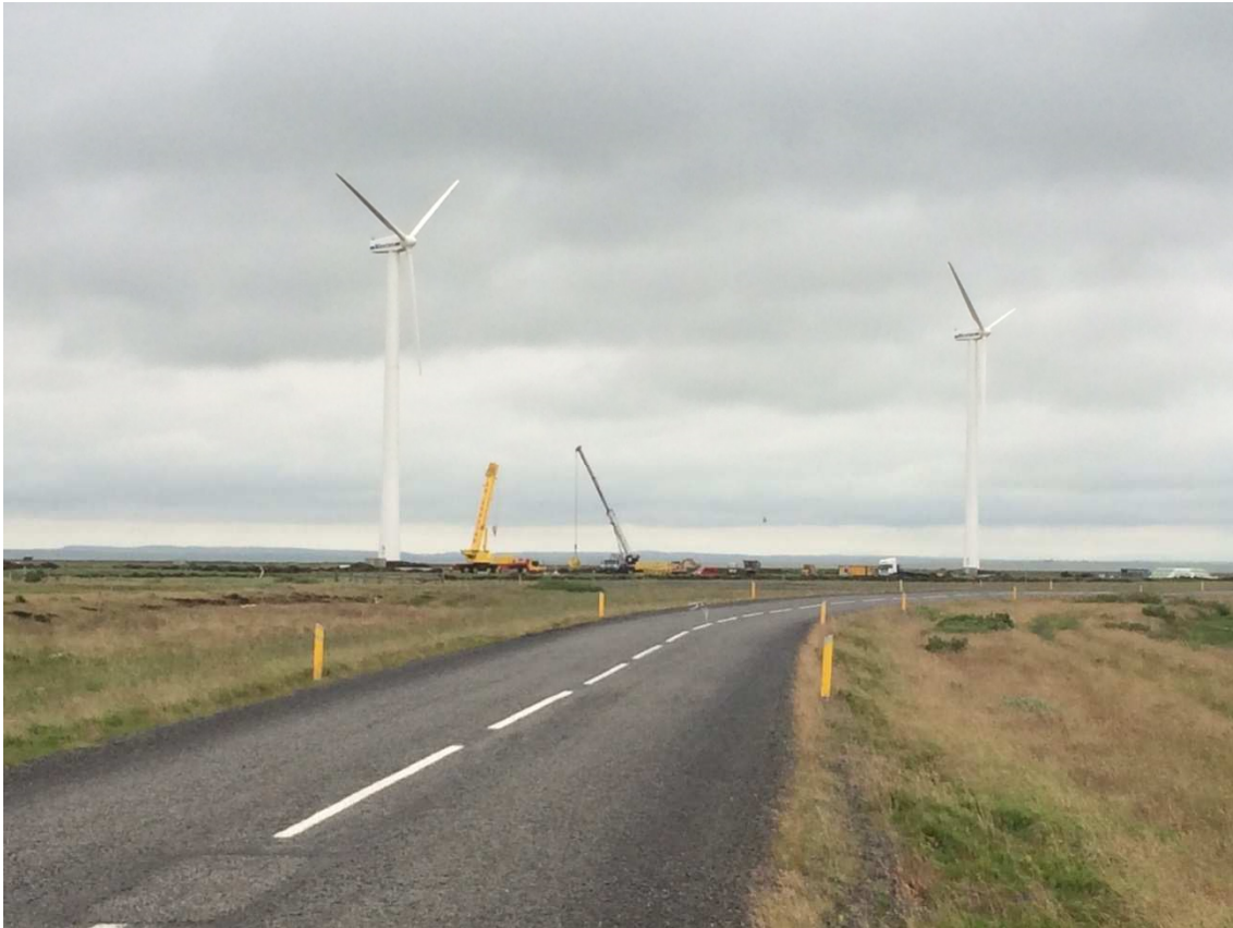
Mynd 4-3: Vindmyllur í Þykkvabæ.
