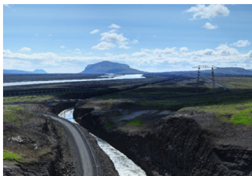
Mynd 36. Ljósmynd F tekin til suðurs frá Sultartangavirkjun yfir frárennslisskurð virkjunarinnar, Búrfell og Bjölfell í bakgrunni.
