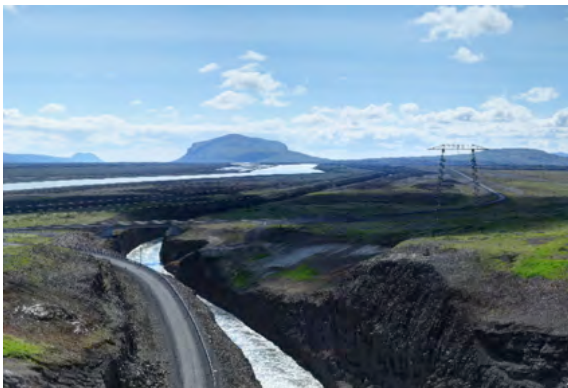
Mynd 56. Ljósmynd F tekin til suðurs yfir frárennisskurð Sultartangavirkjunar með Búrfell í baksýn.
