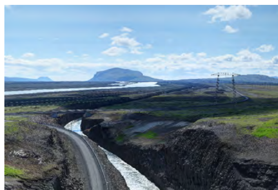
Mynd 68. Ljósmynd F tekin til suðurs frá Sultangavirkjun yfir frárennslisskurðinn og með Búrfell í bakgrunni.
