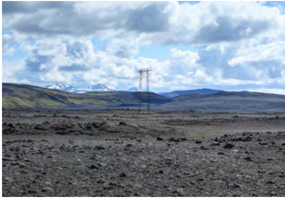
Mynd 58. Ljósmynd B tekin til austurs yfir sandauðn með háspennumastur í forgrunni.
