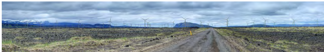
Mynd 119. Ljósmynd E tekin af þjóðvegi F26 til suðurs og sýnir 64 metra háar vindmyllur í 1,5 km fjarlægð.
