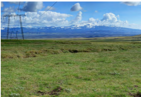
Mynd 54. Ljósmynd E tekin til austurs með háspennumöstur í forgrunni og Heklu í baksýn.
