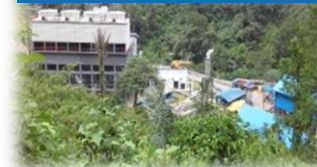
Ulumbu 10 MW East Nusa Tenggara
