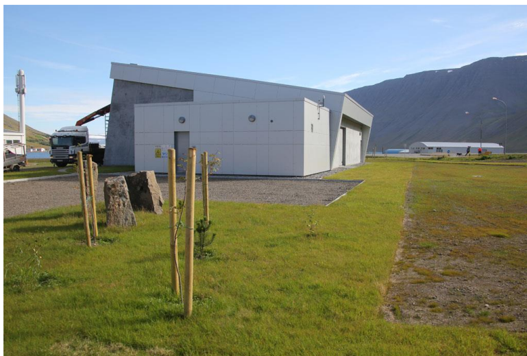
Mynd 7. Nýtt tengivirki á Ísafirði.
