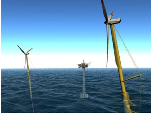
Mynd 10: Fljótandi framtíðarvindorkuver úti á sjó; hugmynd norska fyrirtækisins Sway í samstarfi við NorskHydro.
