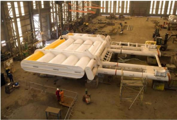
Mynd 29: Unnið að samsetningu á ölduorkuvirkjuninni Oyster hjá skoska fyrirtækinu Aquamarine Power.
