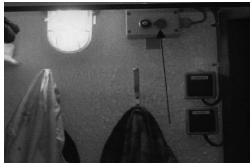
Mynd 2. Örin sýnir rauða hnappinn á afhleypirofa. Læsing fyrir lykilinn er við hliðina.
