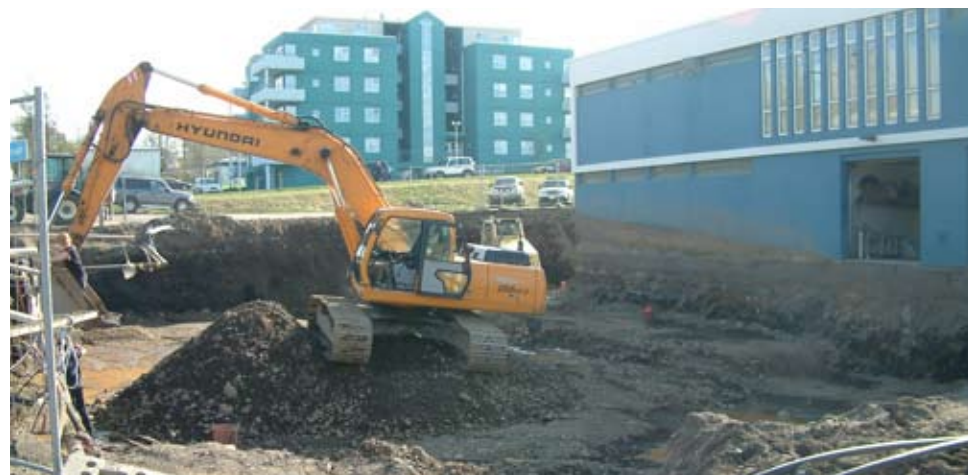
Framkvæmdir við Fangelsið Akureyri.
