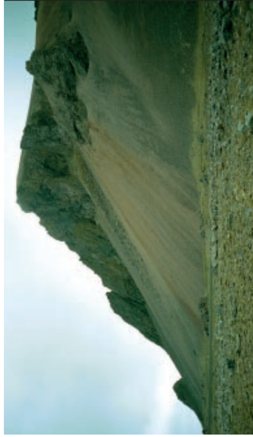
Mynd 6.11: Dæmi um lagfæringu: Efnistaka úr námu í Hvalnesskríðum. Lögun bláðarinnar er halditð eims og kostur er við efnistökuuna.
