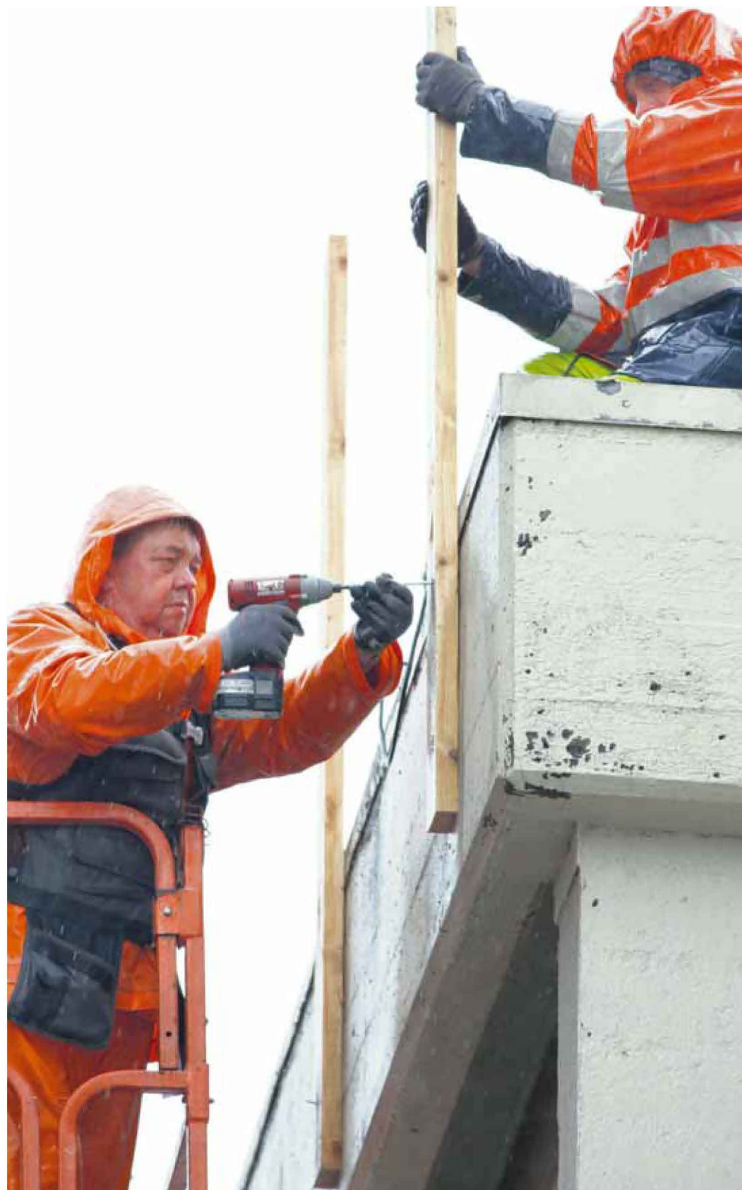
Elja Þessir kappar létu ekki vætu og strekking á sig fá þegar þeir settu upp grindverk í Sundahöfn.
